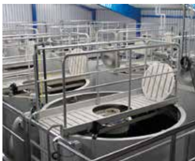
Wolnostojący filtr DynaSand dostarczany jest z platformą umożliwiającą łatwy dostęp w czasie kontroli i serwisowania
