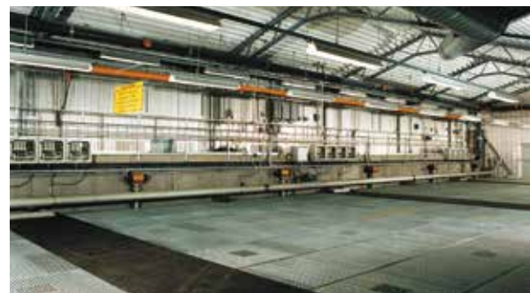
Zbiornik filtracyjny pokryty posadzką
