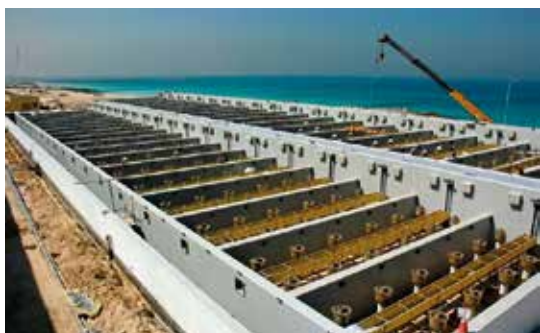
Instalacja odsalania wody w Dubaju oparta na filtrach DynaSand.
