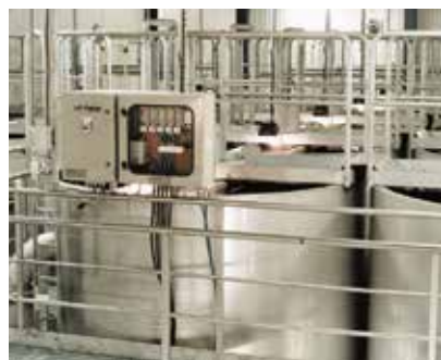
Wolnostojący filtr DynaSand dostarczany jest z platformą umożliwiającą łatwy dostęp w czasie kontroli i serwisowania
