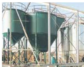
Budowa stacji uzdatniania wody składająca się z separatora płytowego i filtrów piaskowych
